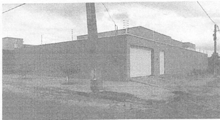
Imagem 02: Fachada Frontal e Lateral da obra
