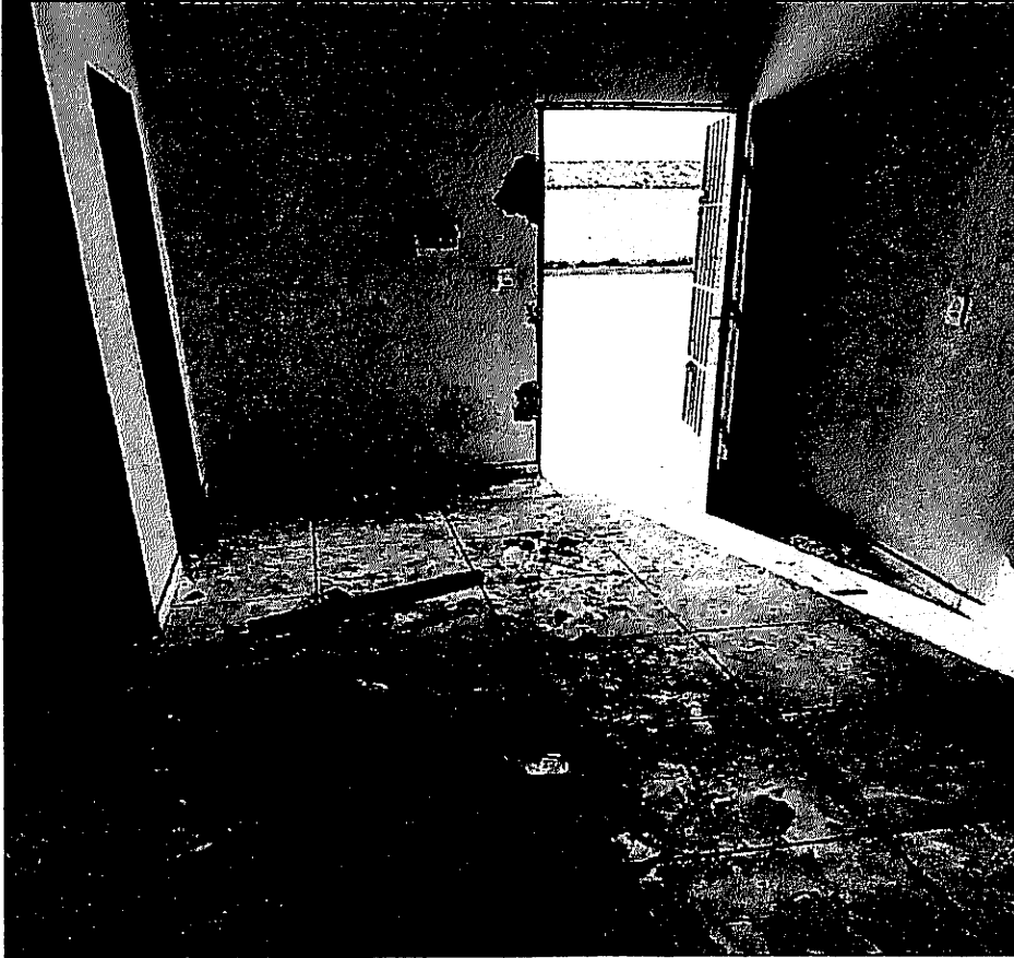
Aspecto interno da edificação existente (3/6)
