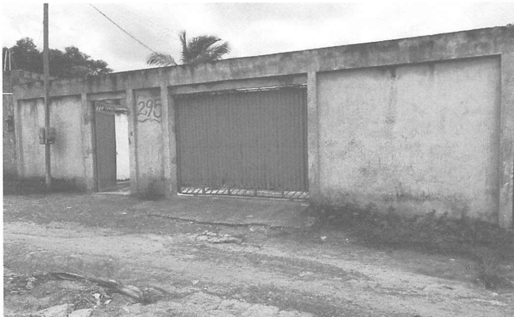
Casa alugada para a Sr. a Inaura Moreira da Silva Sousa localizada na Rua Davi Alves Silva, nº 295, Vila Davi, Buriticupu-MA.
