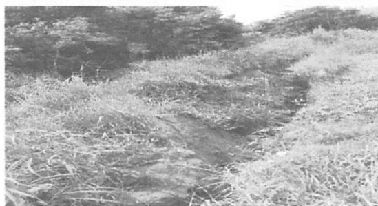
Voçoroca localizada na Rua Tropical, Bairro Terra Bela
