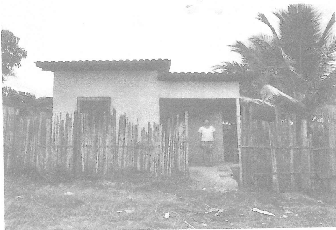
Casa alugada onde reside a Sr. a Iraci Sousa de Sá localizada na Rua Santa Rita, s/nº, Terra Bela, Buriticupu-MA
