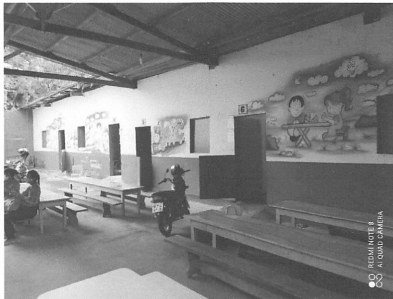
ÁREA DE CIRCULAÇÃO INTERNA
