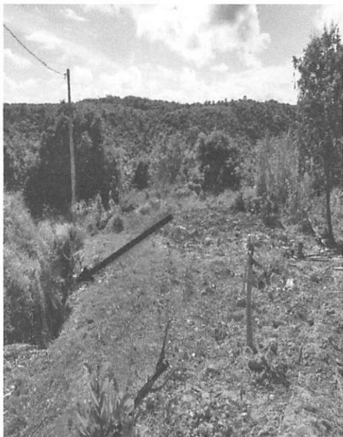
Voçoroca localizada na Rua Tropical, Bairro Terra Bela, Buriticupu-MA
