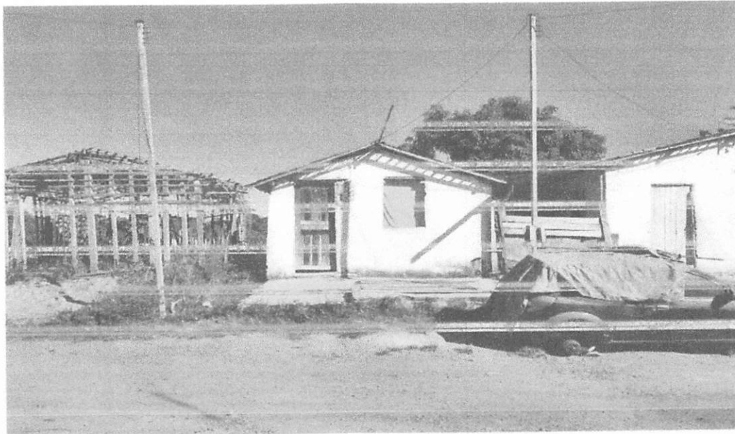
Casa própria onde residia a Sr. ª Inaiara Moreira da Silva localizada na Rua da Dignidade, nº 129, Vila Santa Dumont, Buriticupu-MA
