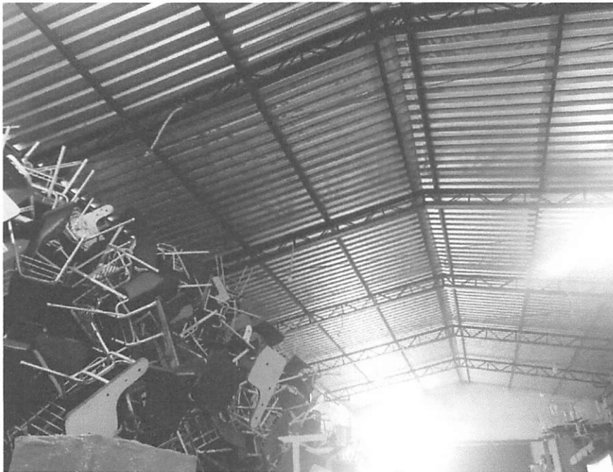
TELHADO DO GALPÃO
