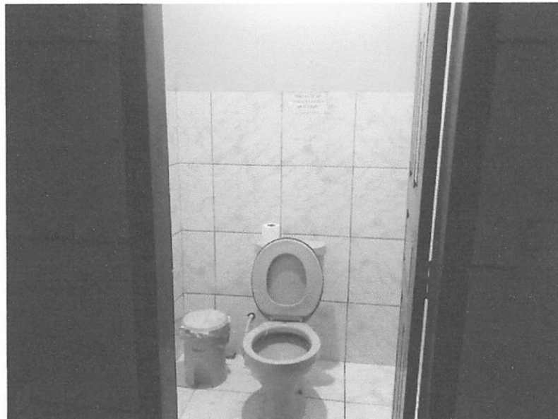
INSTALAÇÃO DO BANHEIRO
