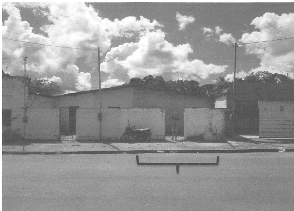
Casa alugada onde reside a Sr. a Ana Lúvia Oliveira Almeida localizada na Rua do Comércio, nº 98, Centro, Buriticupu-Ma.
