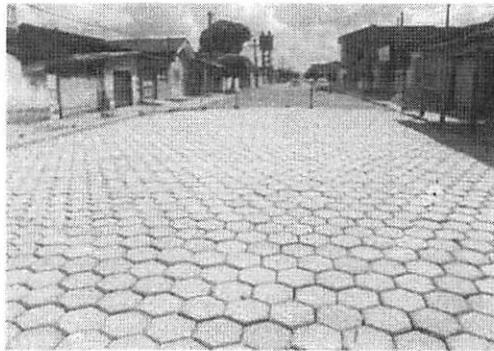
Figura 3 - imagem ilustrativa de Pavimentação em Bloquetes
